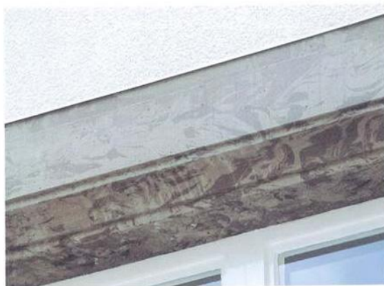
Удачный пример реставрации песчаника с пестрыми природными включениями
