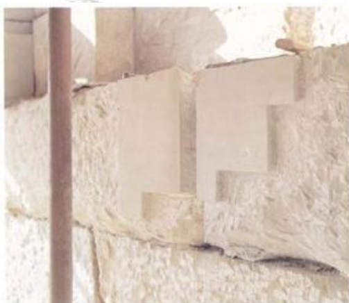
Профессиональная подготовка натурального камня для выполнения дополнений MINÉROS
